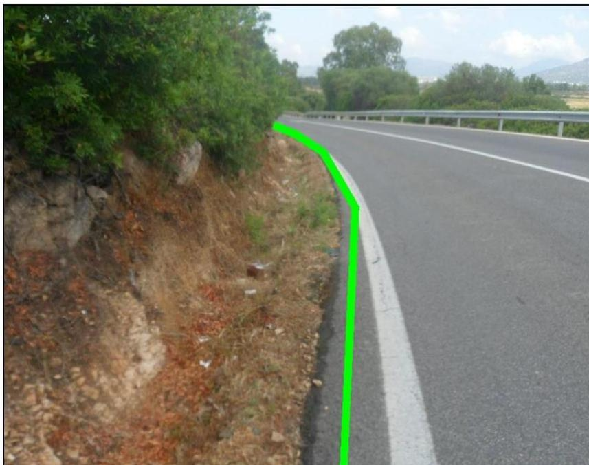
**S.S.125- Sezione in trincea con scarpata in roccia
